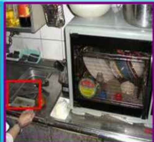
烘碗機水槽積水
